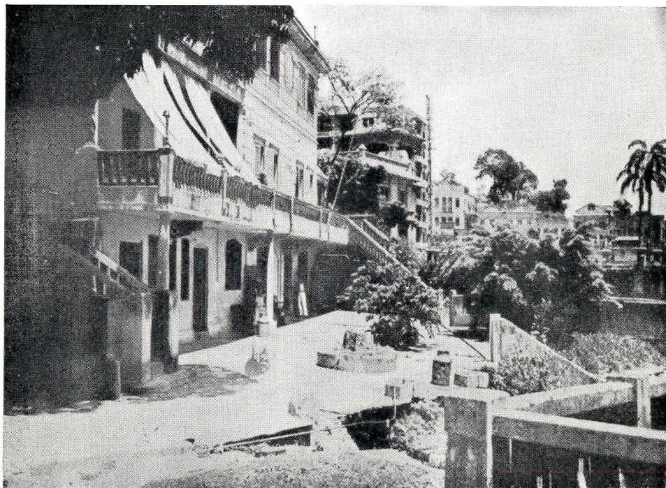
Casarão à rua Conde de Lage, na Lapa, que foi sede do S.N.C. por mais de dois anos, de 1943 a 1946. O pátio ameaçava desabar sobre os prédios vizinhos.
