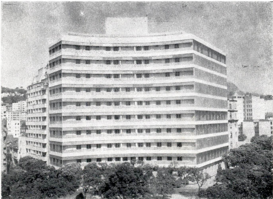
Hospital-Instituto do Serviço Nacional de Câncer, à Praça Cruz Vermelha, iniciado no governo Linhares, construído nos períodos Dutra e Vargas e inaugurado no início da presidência Kubitschek, em agosto de 1957.
