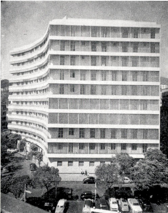
Fachada lateral, Hospital-Instituto de câncer.
