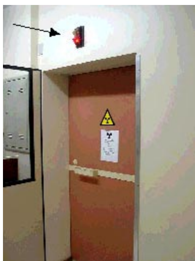
Figura 6. Porta da sala de tratamento. No destaque vemos o sinalizador com a luz vermelha ligada evidenciando que a fonte está exposta
