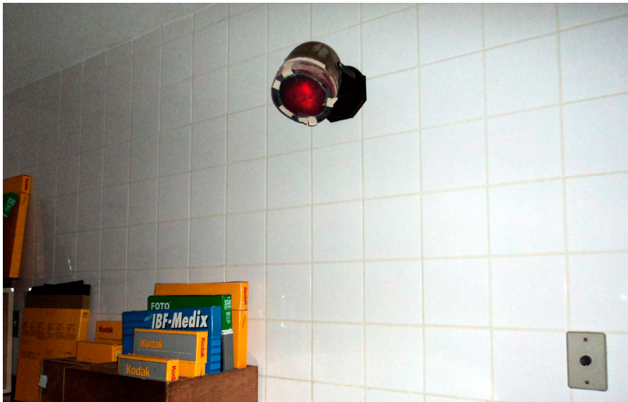
Figura 82. Canhão da luz de segurança da câmara escura
