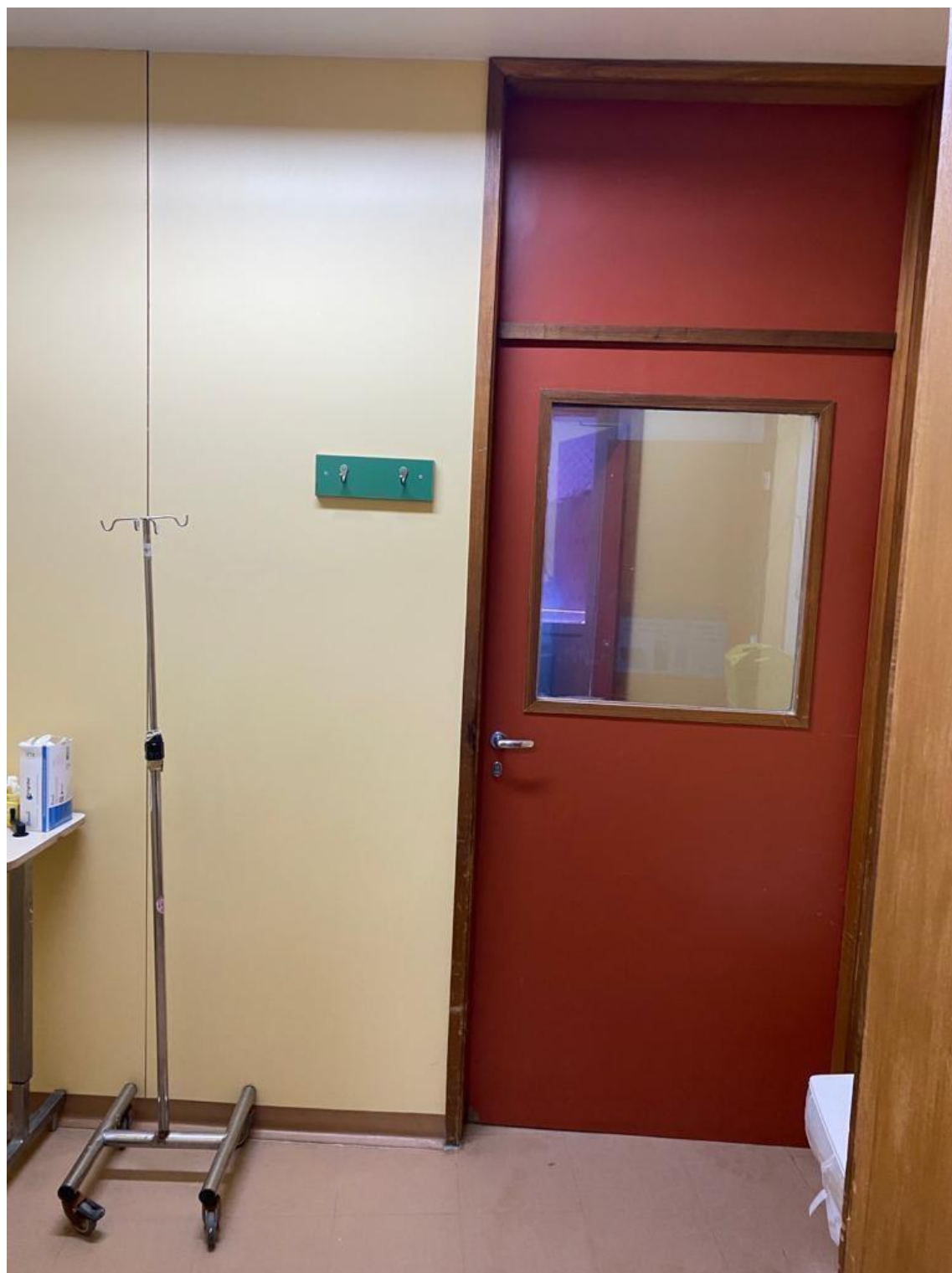
ANTESSALA DA ÁREA DE ACESSO AO ISOLAMENTO
