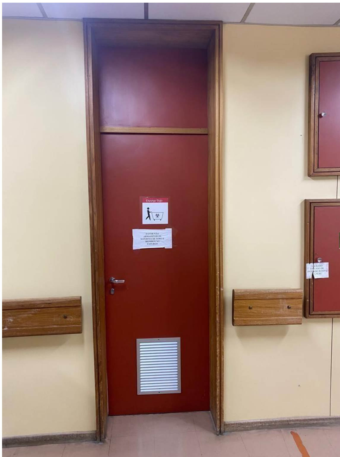
PORTA DE ACESSO À SALA DE EXPURGO
