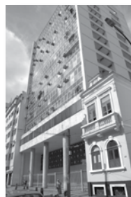
Figura 9. Prédio da Rua dos Inválidos Fonte: Acervo INCA
