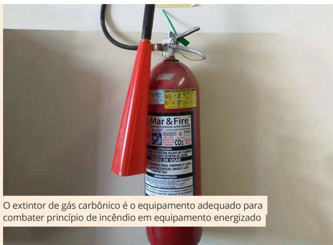
O extintor de gás carbônico é o equipamento adequado para combater princípio de incêndio em equipamento energizado
