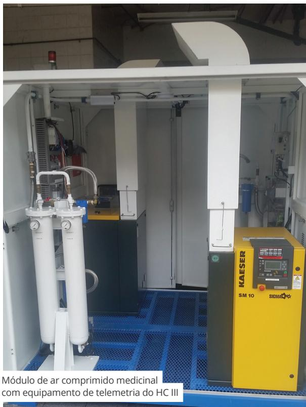
Módulo de ar comprimido medicinal com equipamento de telemetria do HC III
