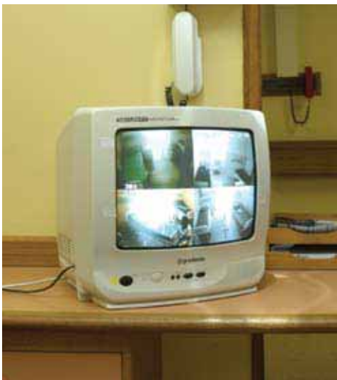
Figura 79 – Monitor do circuito interno de câmera de vídeo
